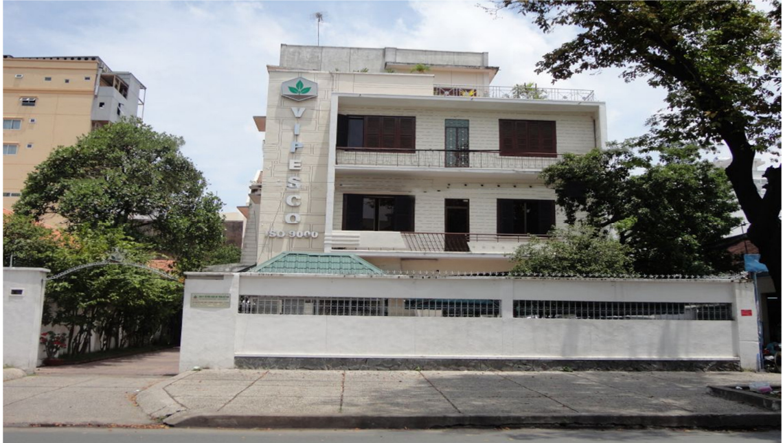
Hình 2: Trụ sở chính Công ty Công ty Cổ phần Thuốc sát trùng Việt Nam
